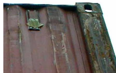
Рисунок 5.20. Заклеенное вентиляционное отверстие
